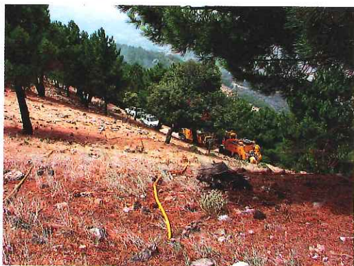
Tendido de mangueras procedente de un equipo de ataque formado por vehículos de extinción ubicados en una pista forestal en la cara oeste de la ladera en el frente noreste del incendio.
