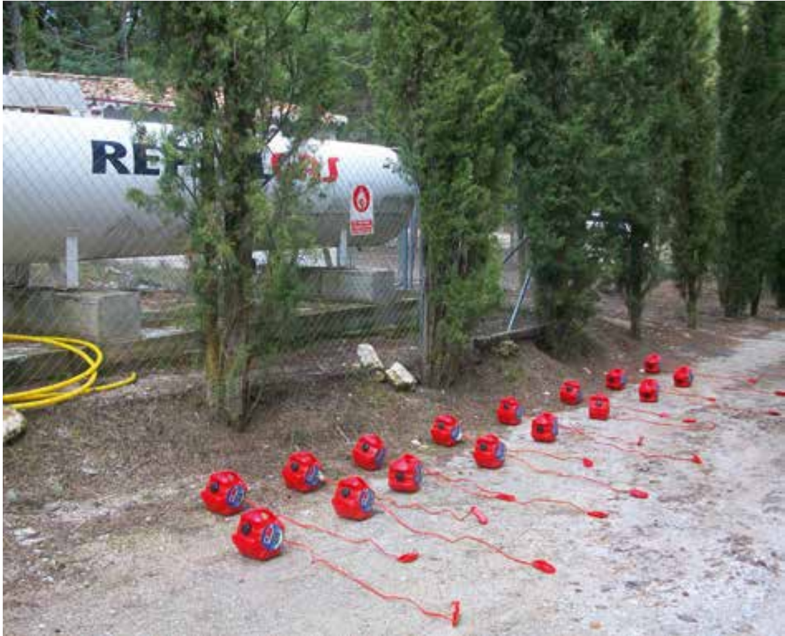
Foto 89: Colocación en paralelo.
