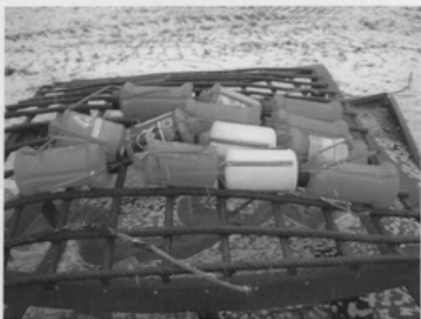
Fotografía 2. Iniciación de la disposición de los contenedores FIRE-CONTROL II sobre la parrilla
