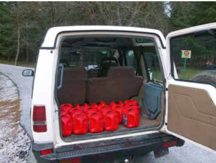
Foto 91: N° de multiextintores disponibles.
