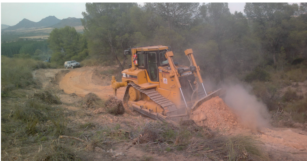
Figura 4 Tractor de cadenas llevando a cabo un acceso para medios terrestres en el incendio de Hellín (Albacete). Foto: autor.
