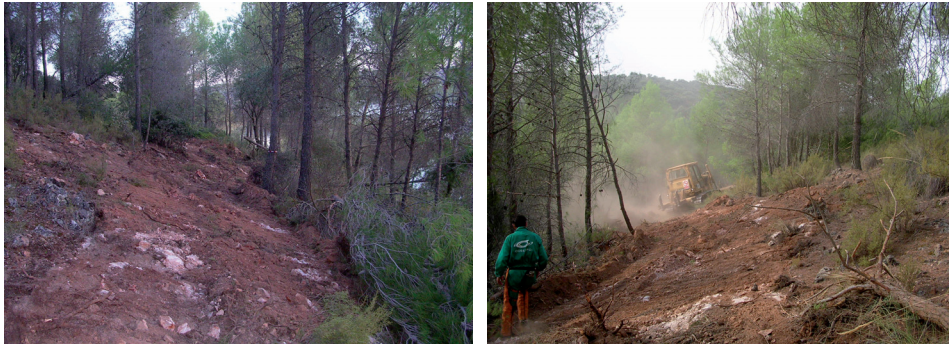
Figura 104 Dificultad de trabajo con tractores debidas a afloramientos rocosos en tareas de apertura de calles de desem-bosque. Ruidera (Ciudad Real). Foto: Autor.
