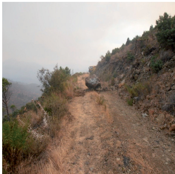
Figura 137 Desprendimiento de rocas en un camino. Foto: Enrique Mérida.
