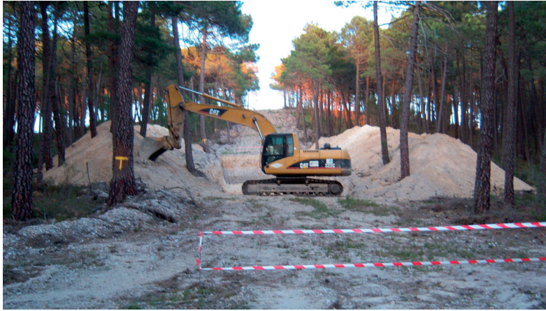
Figura 6 Retroexcavadora trabajando en apertura de un camino. Talveila (Soria). Foto: Blas Andrés.
