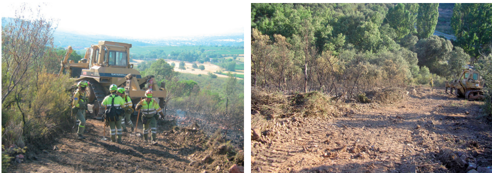
Figura 119 Ejemplos de líneas ejecutadas con tractor de cadenas. Observar zona de excavación y zona de vertido de tierras y restos. Abenojar y Retuerta del Bullaque (Ciudad Real). Foto: Autor.
