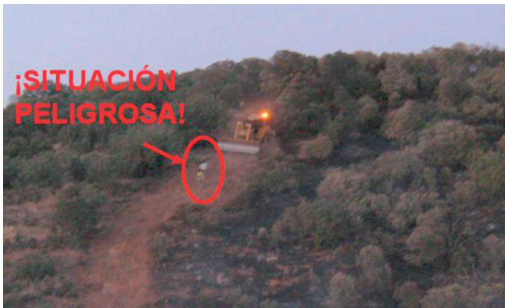
Figura 141 Situación peligrosa de dos trabajadores por debajo del radio de acción del tractor. Retuerta del Bullaque (Ciudad Real). Foto: Urías García.
