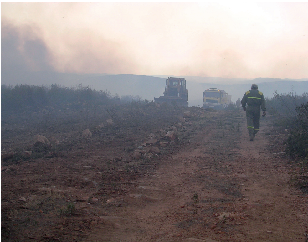
Figura 92 Creación de acceso a autobombas sobre cortafuegos ya existente. Puertollano (Ciudad Real) Foto: Autor.
