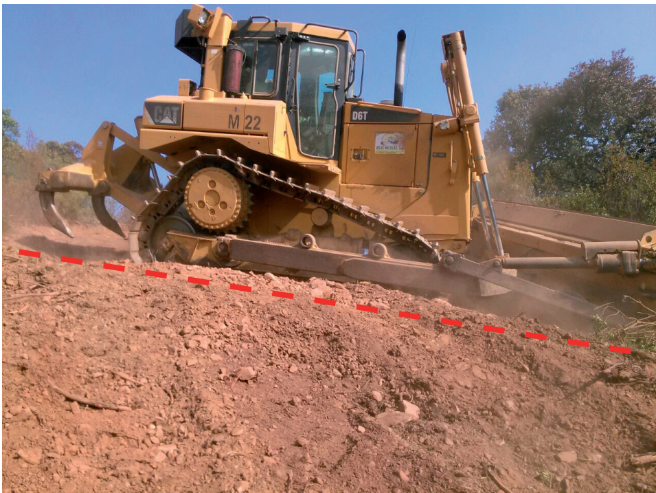
Figura 127 Proceso de ejecución de un caballón desviador con tractor de cadenas. Puebla de Don Rodrigo (Ciudad Real). Foto: Calixto Lucio.
