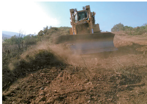
Figura 122 Reducción del tamaño del caballón lateral nivelando el terreno. Puebla de Don Rodrigo (Ciudad Real). Foto: Calixto Lucio.
