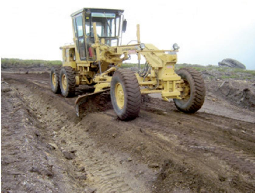
Refino de la plataforma del camino con motoniveladora
