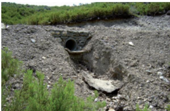
Ejemplo de paso mal colocado en el que el agua está provocando erosión que acabará por destruir el paso.
