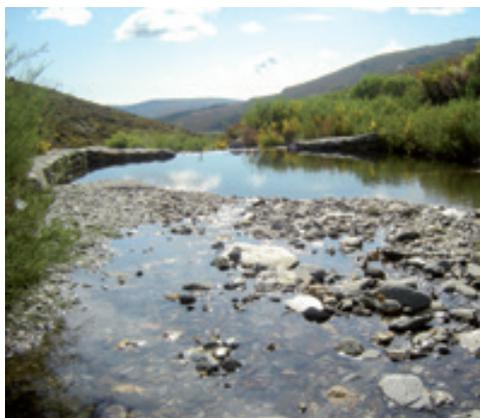
Ejemplo de punto de agua construido en medio de un cauce y que ya está prácticamente colmatado por los arrastres.
