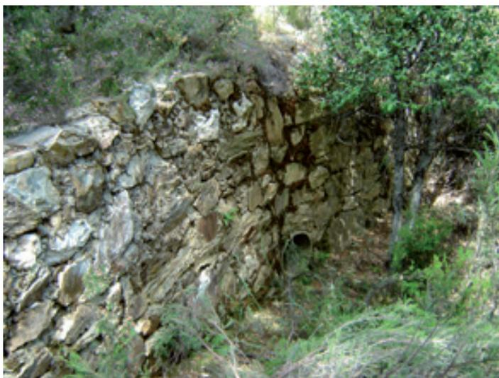
Ejemplo de muro de piedra construido en un paso de agua de 50 cm. de diámetro. Nótese como los tubos se han colocado sobre el fondo de la vaguada.
