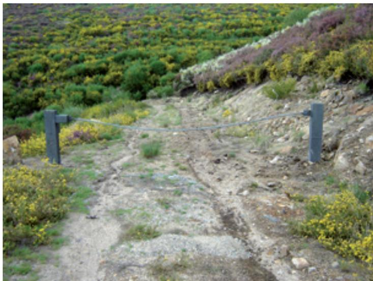
Ejemplo de cierre recomendado. El cable se suelta solamente de uno de los postes y los vehículos pasan por encima del cable. El extremo del cable que se suelta, se sujeta al poste mediante una pieza con agujero en la que se inserta un bulón que no puede separarse del poste. El bulón dispone de un sistema de cierre con llave que sería utilizado en caso necesario.
