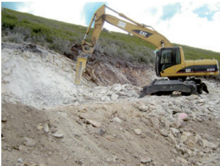
Demolición de roca con retroexcavadora y martillo hidráulico
