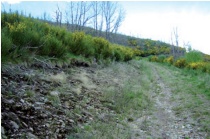
Ejemplo de proceso de colonización de la vegetación en un talud. Se trata de un camino de tercer orden sin cuneta y el talud del camino se realizó con bulldozer. La pendiente del talud es de 1,5:1.
