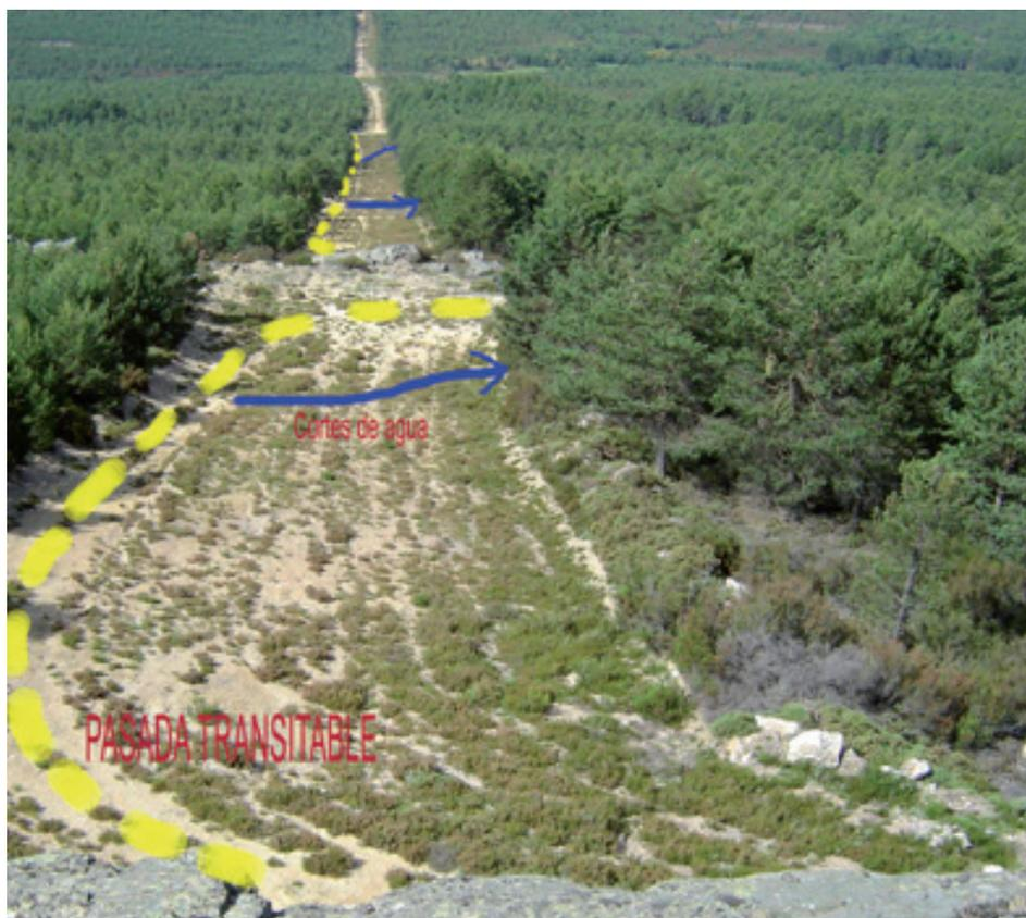
En el ejemplo puede comprobarse que la pasada transitable del cortafuegos se sitúa en la parte superior de los cortes de agua.
