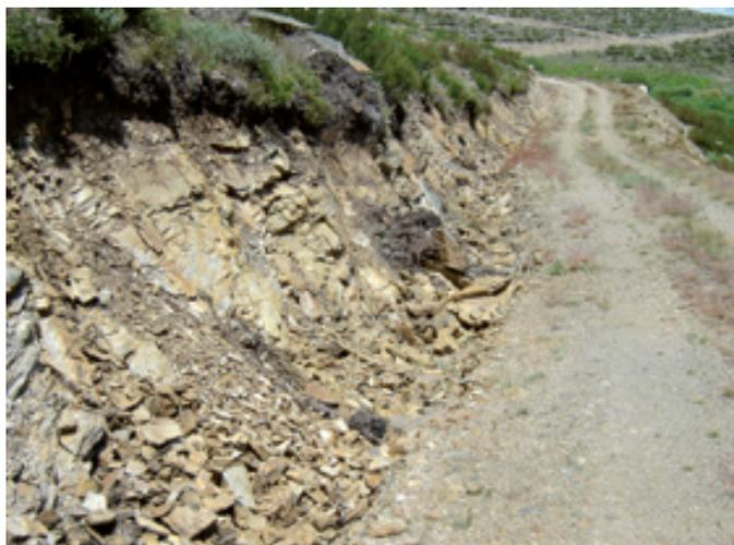
Ejemplo de talud construido con una pendiente incorrecta y en el que se han empezado a producir desprendimientos.
