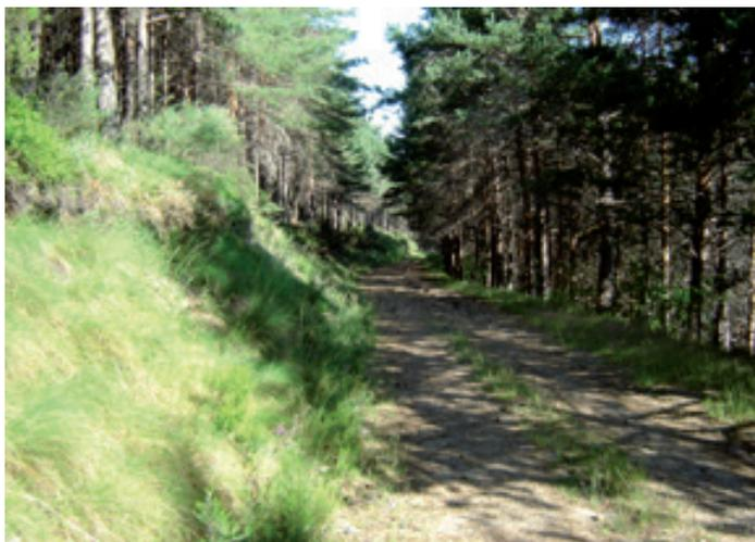
Talud del camino cubierto de vegetación, la cual impide su erosión
