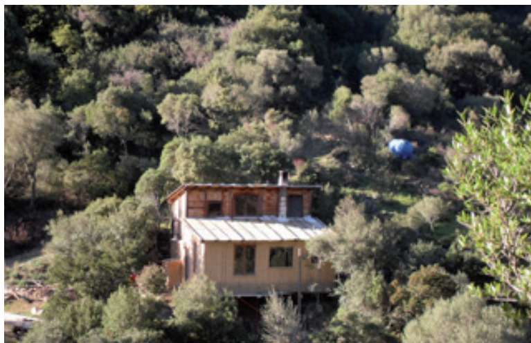
¿Considerarías esta estructura como zona segura? (J.L. Duce 2013)
